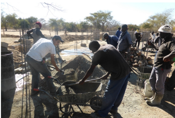
Bild 6: Arbeiten am Kindergarten
