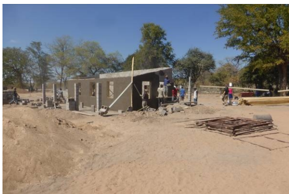
Bild 5: Mauerwerk der Schulküche
