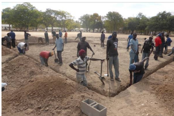
Bild 3: Einebnung des Bodens
