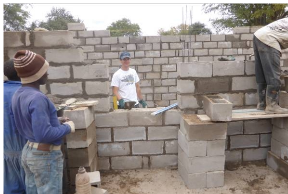
Bild 4: Mauerarbeiten an der Küche
